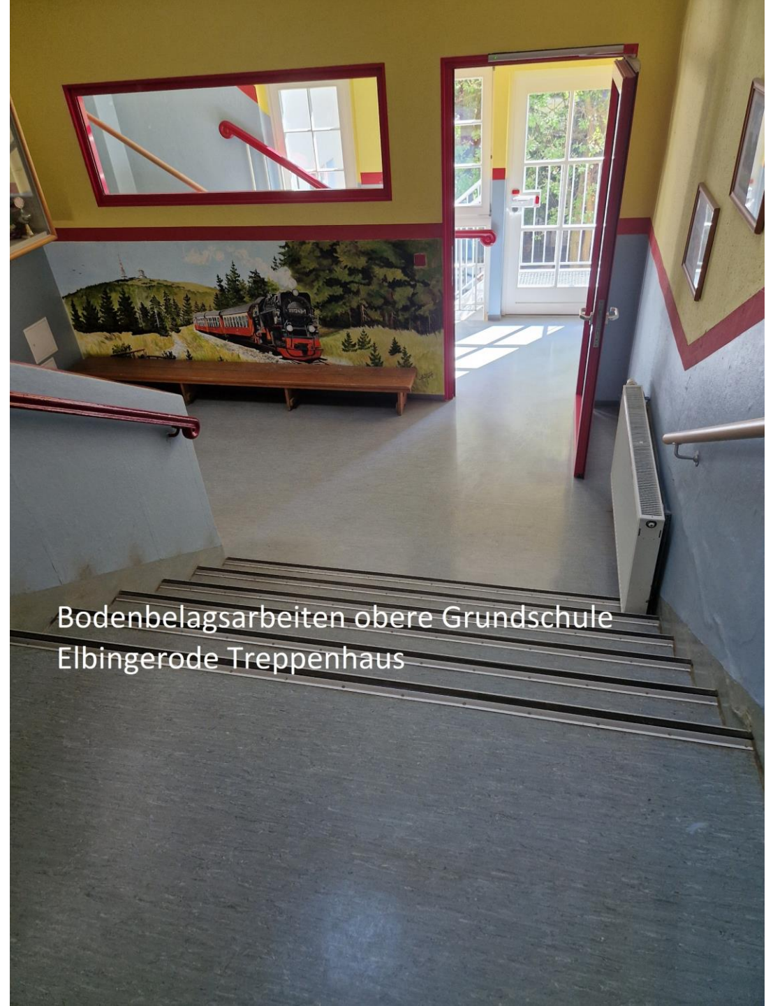
Bodenbelagsarbeiten obere Grundschule Elbingerode Treppenhaus
